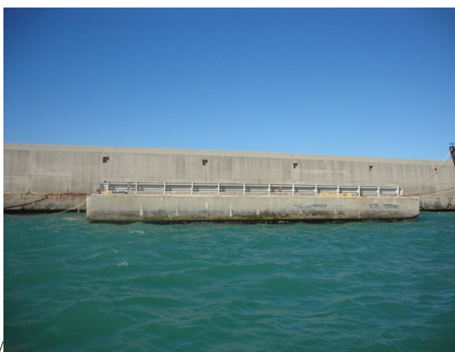
Figura 30 Specchio d'acqua, antemurale lato interno. Banchina (Punto P3)
