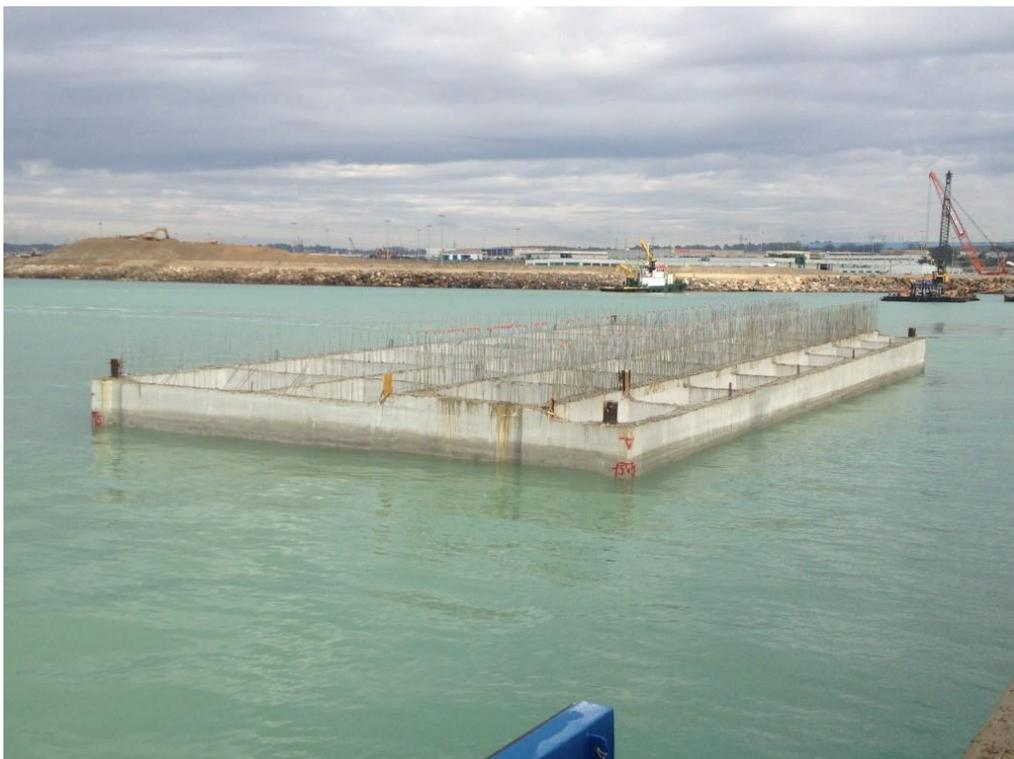
**Fig. 38 - Costruzione del dispositivo REWEC3 nella nuova darsena di Civitavecchia**
