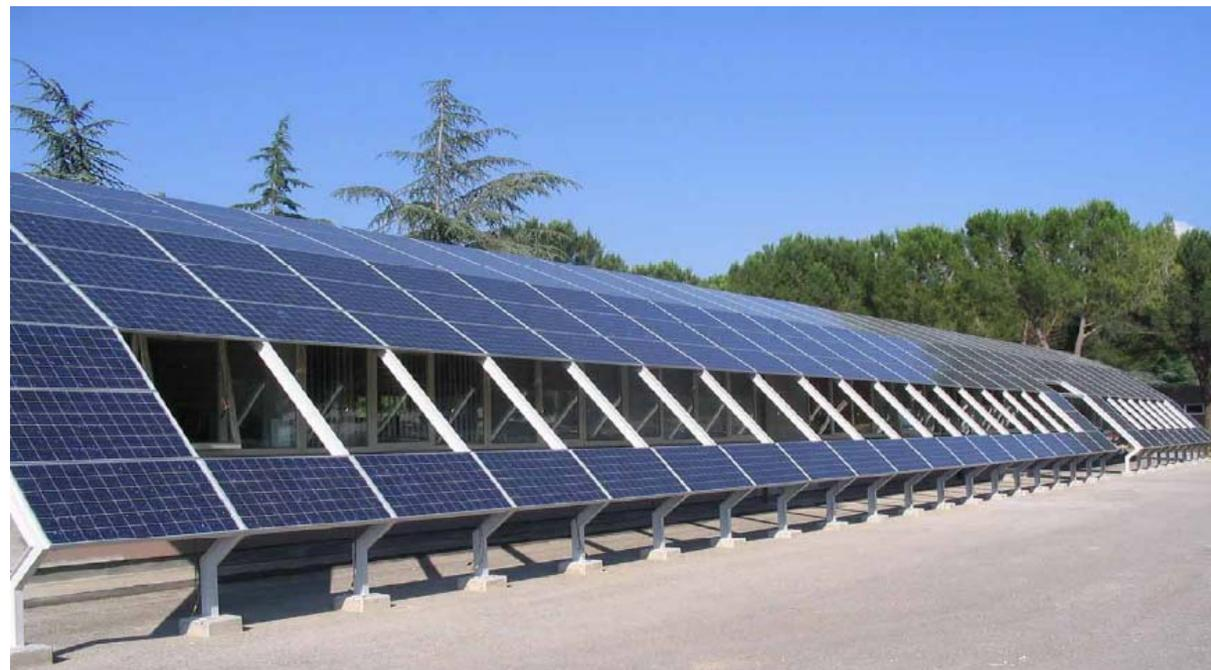
Impianto fotovoltaico localizzato nel Comune di Narni (TR), costituito da 252 moduli di potenza unitaria pari a 160 W.
