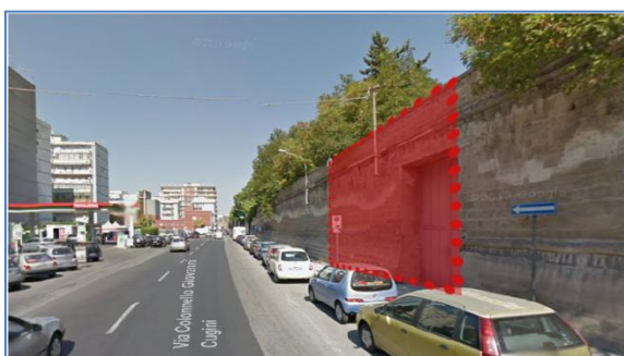
Taglio sul Muraglione dell’Arsenale all’incrocio fra Via Giobatta Magnaghi e Via Colonnello Giovanni Cugini 20 x 7 m
