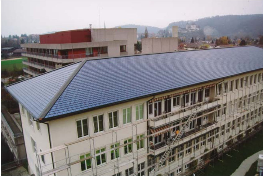
Complesso ospedaliero di Burgdorf (GE)
