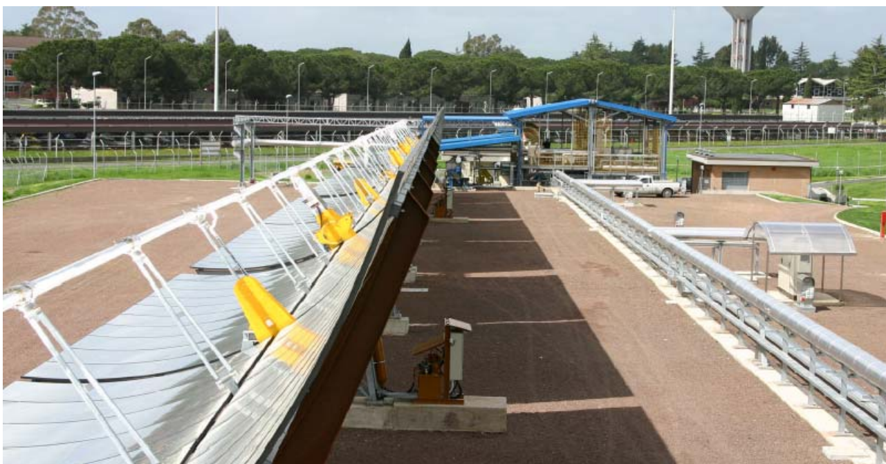
Fig. 30 - Foto panoramica del circuito PCS con 2 collettori in prova
