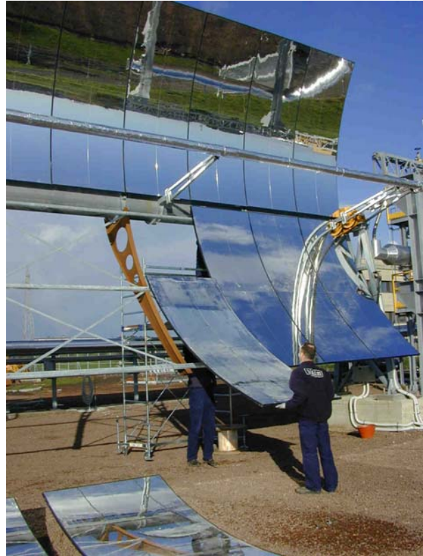
Fig. 16 - Montaggio degli specchi di prima generazione (Powerwall)
