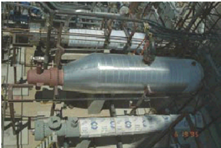
Figura 21. Vista dall'alto del generatore di vapore dell'impianto SOLAR TWO
