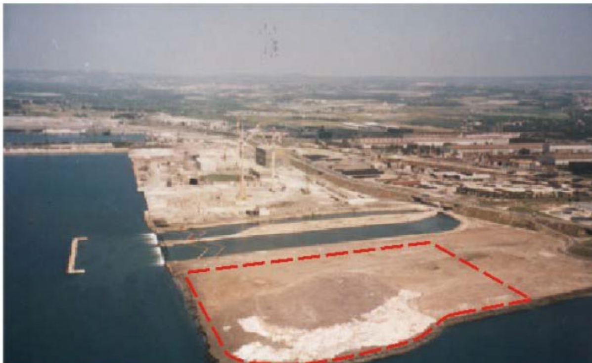
Fig. 22.1 – Vista aerea dell'area in cui sorgerà il terminale di GNL.
