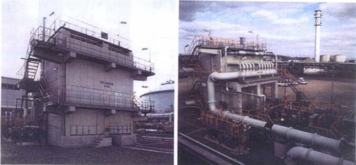
**Fig. 2.2** - Immagine di vaporizzatori "Open Rack" ("a ruscellamento d'acqua")
